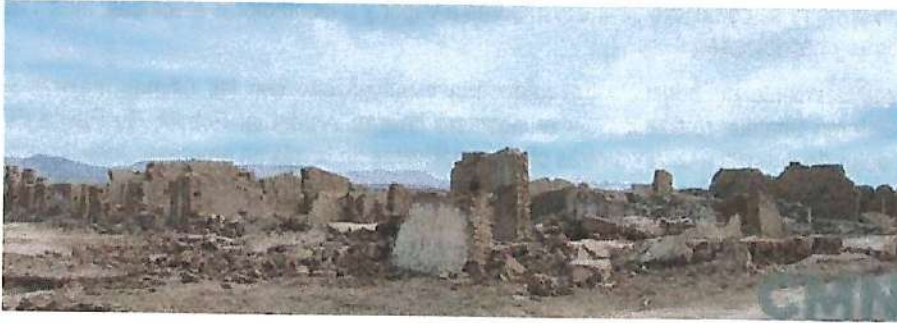
Figura 28. Ruinas del pueblo Pampa Unión
