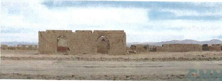
Figura 29. Ruinas del pueblo Pampa Unión
