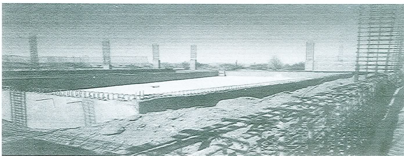
Obras Piscina Semiolímpica.
